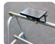
単管バリケード設置
