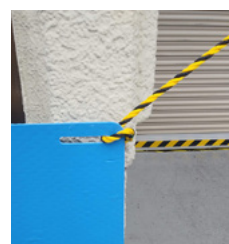
念のため土のう・水の入ったペットボトルなどの重しやロープで固定することをお勧めします。
